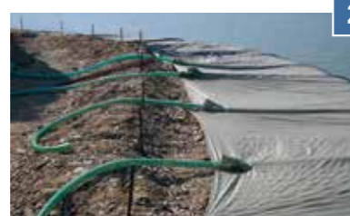
Extendido de los paneles
