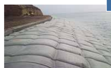
Relleno de los paneles con hormigón/cemento
