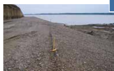
Preparación de la superficie
