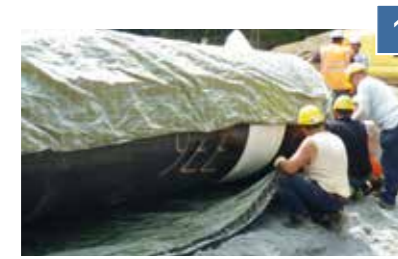
Fijado a la sección de la tubería
