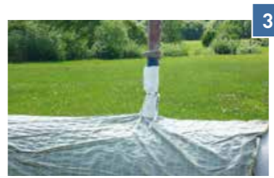
Hormigonado por las bocas de llenado
