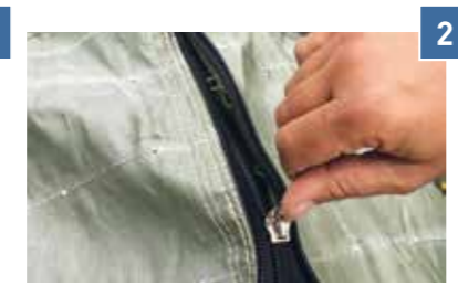
Unión por cremalleras de paneles IPC
