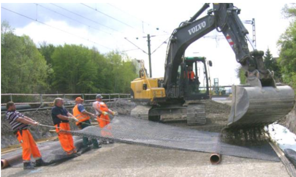
Bild 8: Anspannen und Fixieren eines Geogitterrückumschlages
