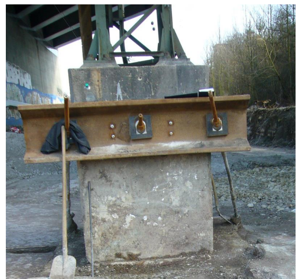
Bild 7: Bauzeitliche Sicherung eines Mastfundaments
