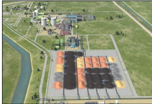
Figura 1. Esquema general de la planta de acero TKCSA: Pilas de disposición de materiales y pistas para las máquinas recuperadoras.
