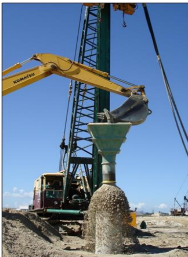
Figura 9. Ejecución de las columnas GEC (tolva y retroexcavadora de llenado).
