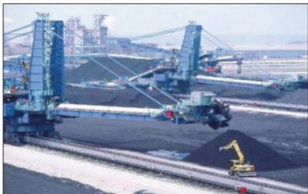
Figura 4. Patios de almacenamiento de carbón y coque: pilas de materiales y pistas con las máquinas de apilamiento y recuperación de 750 toneladas operando entre ellas.
