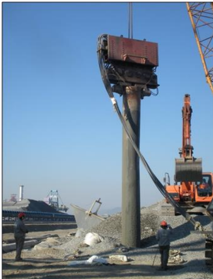
Figura 8. Ejecución de las columnas granulares encamisadas (tubería metálica y martillo vibratorio).
