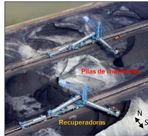
Figura 3. Patios de materiales; arriba (Norte) carbón/coque, abajo (Sur) mineral de hierro/aditivos, Pistas para las máquinas de apilamiento ( stacker/reclaimers ) operando en el sentido Oeste-Este.
