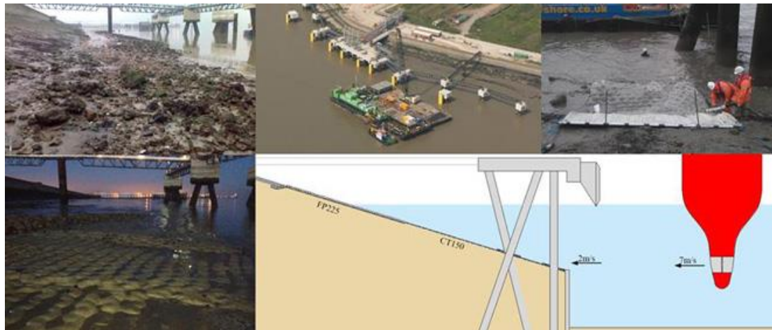
Figura 13.- Instalación del nuevo sistema de control de erosión en talud portuario - Muelle Shell.
