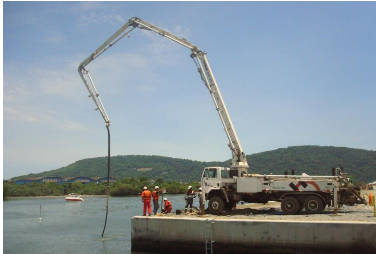
Figura 12. Llenado mediante bomba de concreto desde tierra.
