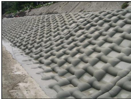
Figura 2. Principales tipos de encofrados geotextiles para hormigonado – De arriba para abajo: Colchón de sellado, colchón flexible, colchón de puntos filtrantes y colchón para vegetación.
