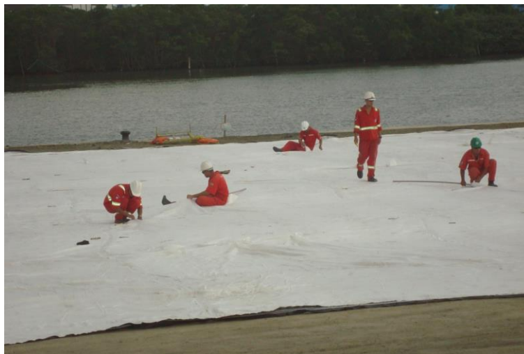
Figura 9. Preparación de las tuberías flexibles de llenado dentro del encofrado geotextil.
