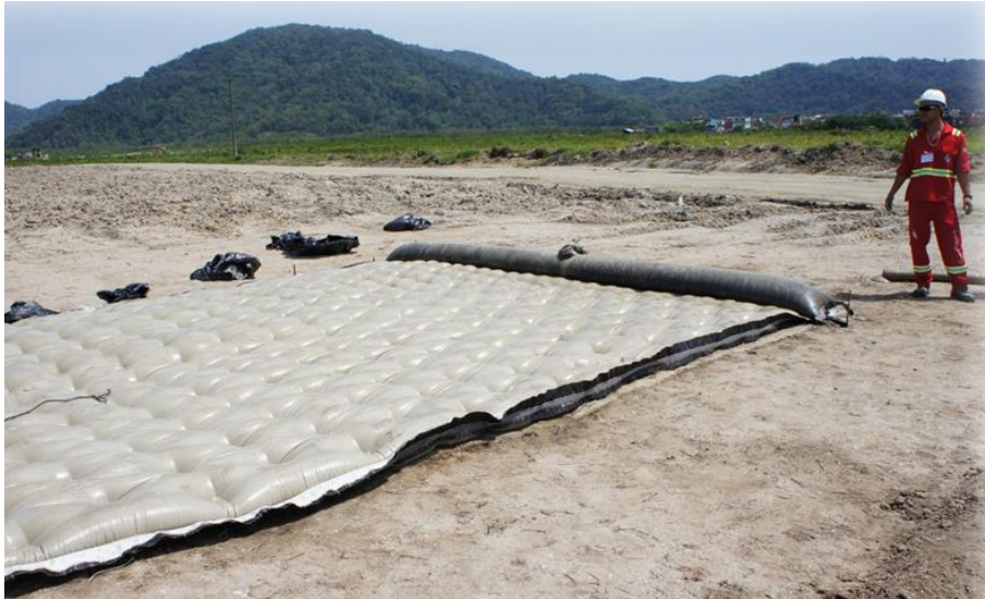
Figura 8. Prueba piloto en tierra – evaluación del tubo de lastre.
