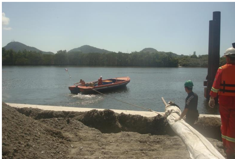
Figura 11. Posicionamiento del encofrado mediante el auxilio de embarcaciones.
