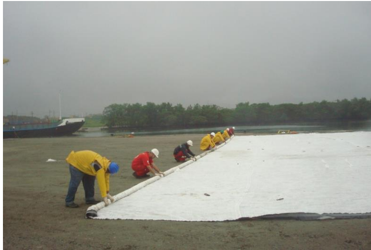
Figura 10. Preparación de los paneles en tierra.
