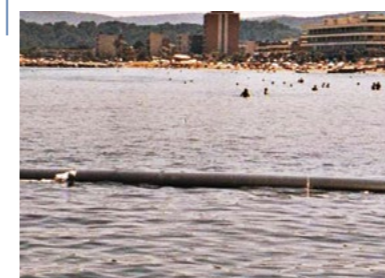
2002 Le Lavandou Francia Rompeolas SoilTain® Tubos de Protección de Costa
