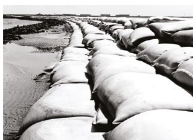
1963 Rüstersieler Watt Alemania Construcción de dique SoilTain® Sandbags
