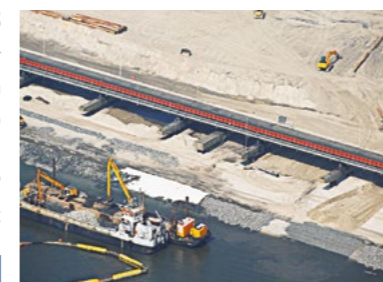
2008 Puerto JadeWeser Alemania Revestimiento HaTe® Non Woven Tektoseal® Sand mat
