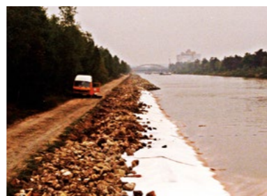
1989 Canal Mittelland Alemania Revestimiento HaTe® Non Woven
