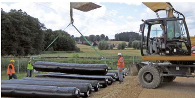
Figura 6: Almacenaje de las bobinas en la obra y empleo de auxiliares de elevación/tendido
