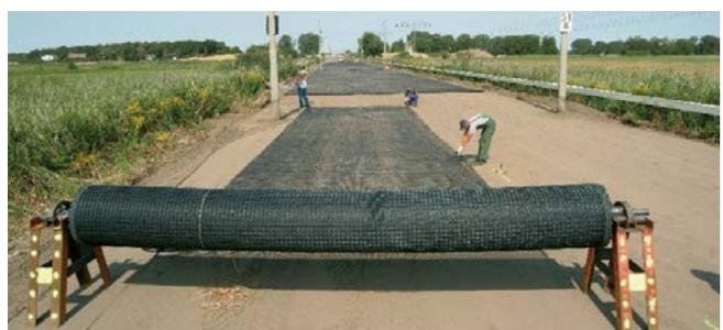
Figura 8: Un caballete de desenrollado facilita el recorte de las bandas
