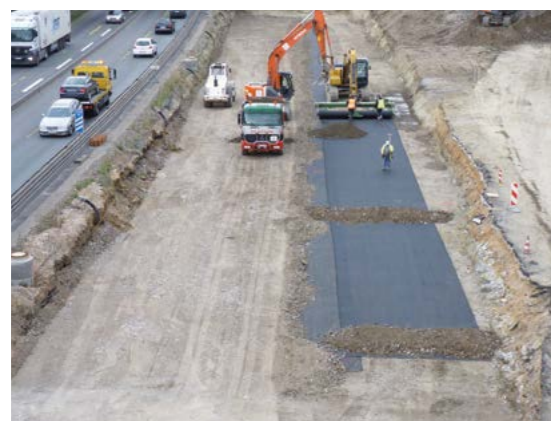
Puente de subsidencia (Autopista Bochumer Westkreuz (A 52), Alemania)
