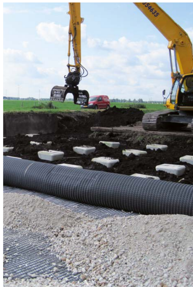
Refuerzo con geomalla sobre pilotes (N 210; Países Bajos)
