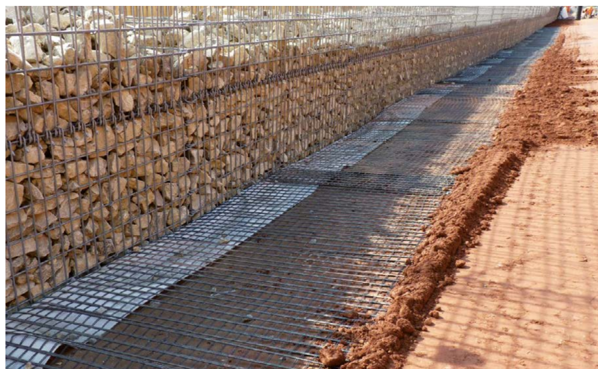
Muro de gaviones reforzados (Autopista A3 cerca de Haseltal, Alemania)
