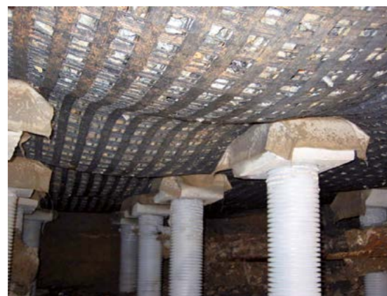
Efecto membrana en aplicación de terraplén pilotado (Línea ferroviaria Bidor-Rawang, Malaysia)
