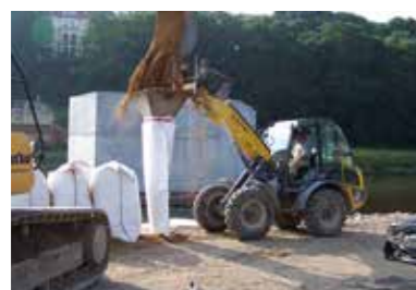
Llenado mecánico mediante tolva, excavadora
