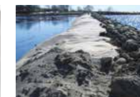
Capa de cobertura
