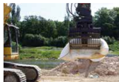
Instalación con ayuda de una excavadora o similar
