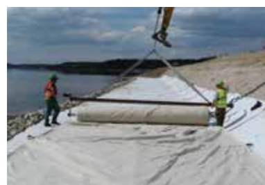
Colocación de los tubos (con ayuda de útil)
