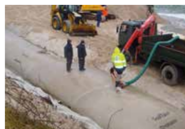
Llenado de los tubos (draga de succión, bomba de lodo)
