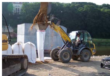
Llenado mecánico mediante tolva, excavadora
