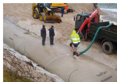
Llenado de los tubos (dragas de succión, bomba de lodo)
