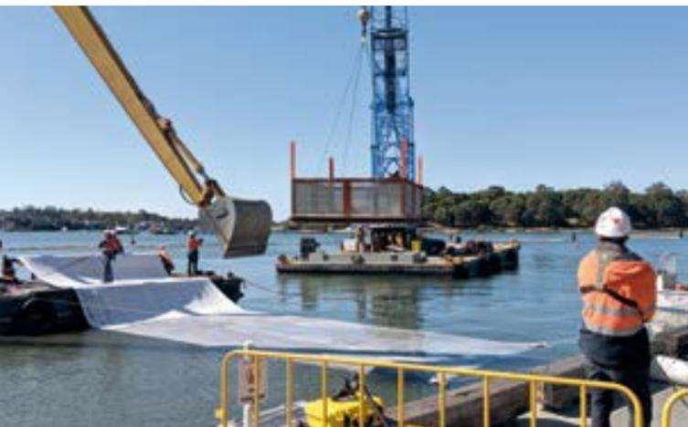
**Aseguramiento de los sedimentos contaminados**
