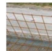
Mallazo metálico como encofrado
