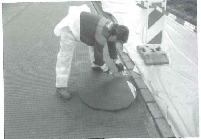
Fig. 5 - Taglio della geogriglia attorno ad un tombino
