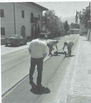
Fig. 4 - Posa con macchinario e posa manuale. Rotoli di diversa larghezza.
