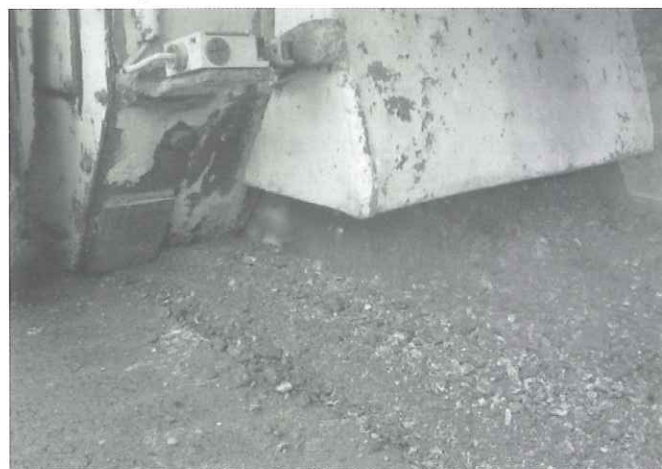
Fig. 22 - Scarifica di conglomerato bituminoso rinforzato con geogriglia in PET
