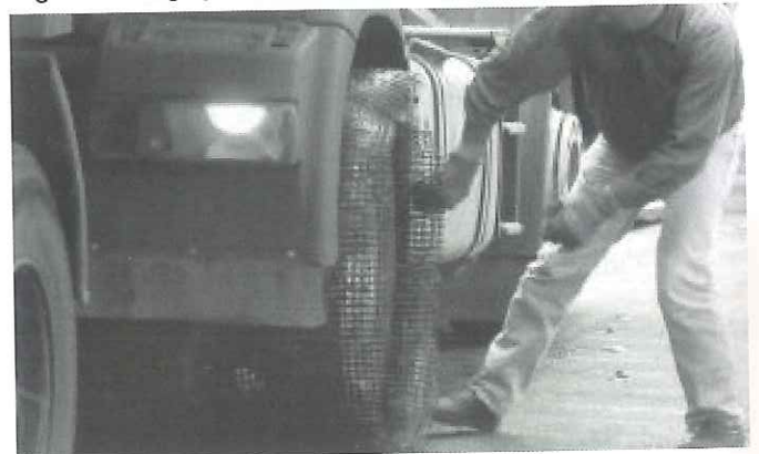
Fig. 7 - Geogriglia con problemi di aderenza
