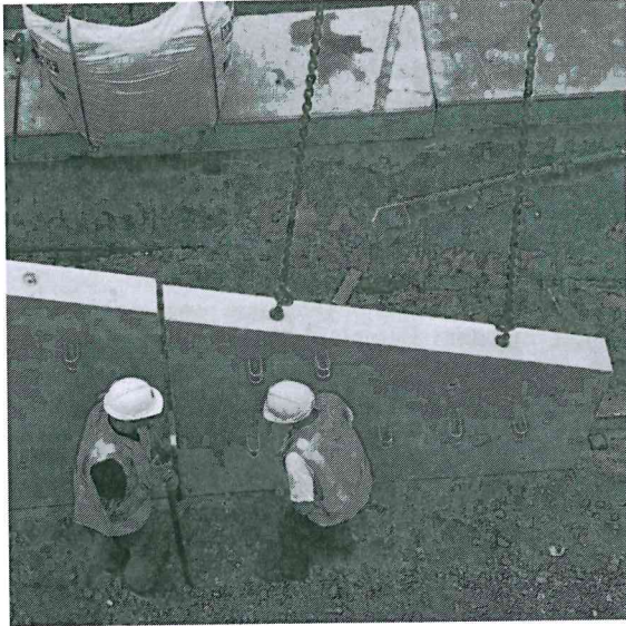
Abbildung 8 Transport der Betonfertigteile
