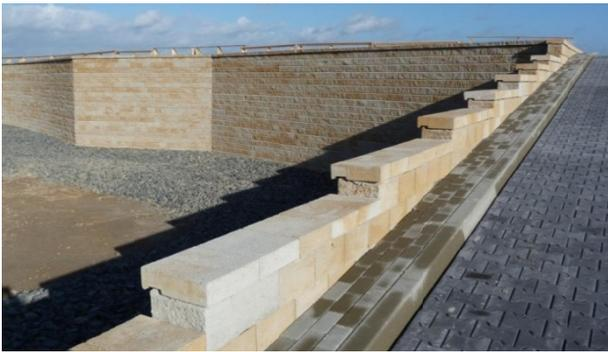
Bild 3: Blocksteinmauer mit Sliprampe kurz nach Fertigstellung der relevanten Arbeiten
