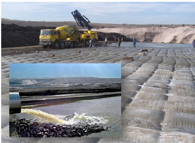
Bild 9: Sohlensicherung mittels Betonmatten
