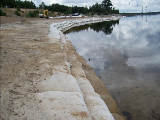
Bild 8: Einbau der GSC als Böschungssicherung
