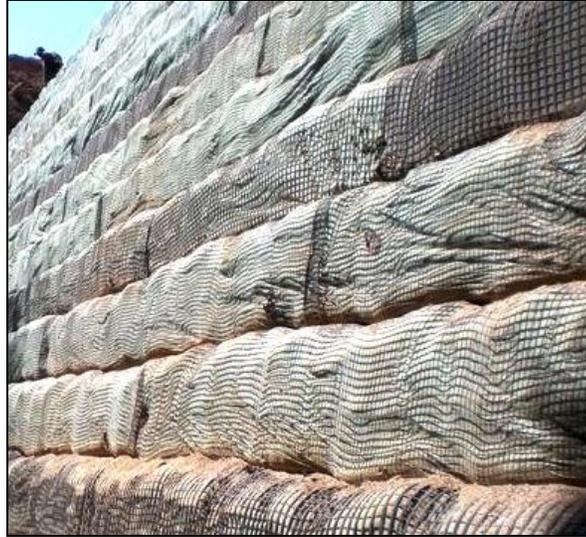
Figura 7. Detalle de la cara vista durante la construcción.
