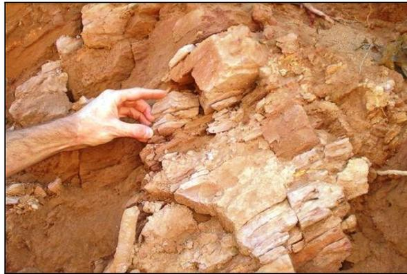
Figuras 5. Detalle de la roca alterada en la fundación.
